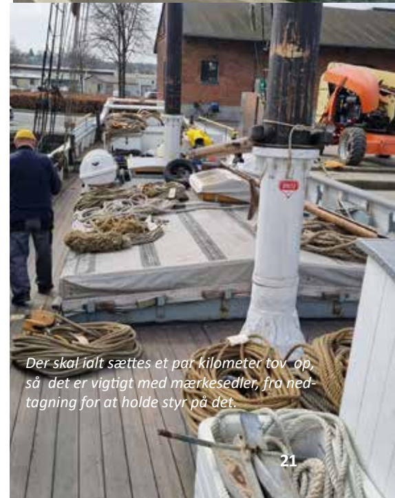
Der arbejdes med lift. Masterne bliver smurt og riggen monteret.
