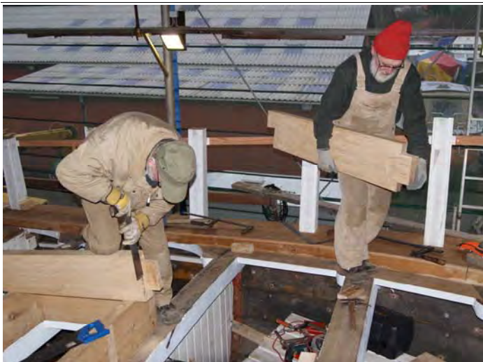
Jørn og Ejvin arbejder med fundamentet til forreste nedgangskap-pe.
